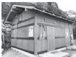
（トイレ施設の壁面を塗替）
